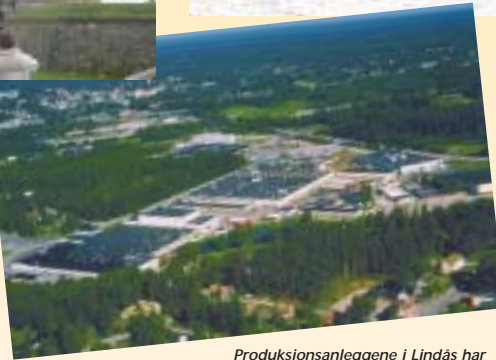
Produksjonsanleggene i Lindås har vokst til ca. 82 000 kvadratmeter.
