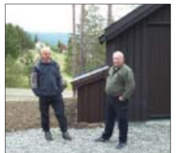
Avdelingsingeniør Johan Lyftingsmo (til venstre) og driftsoperatør Ronald Kikut foran vannbehandlingsanlegget/pumpestasjonen som er levert til Lesja kommune av ITT Flygt AS.
