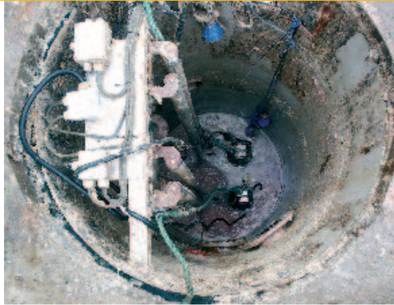
En FP 3127 senkbar avfallspumpe samler alt avfallet fra produksjonen.
